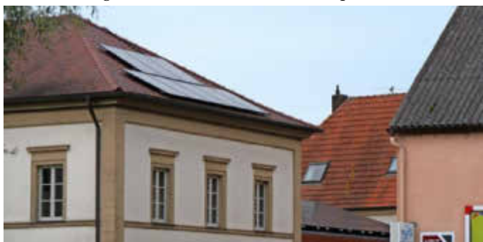
Auf mehreren Dachflächen hat die Kirchengemeinde St. Laurentius eine Photovoltaikanlage bauen lassen.
