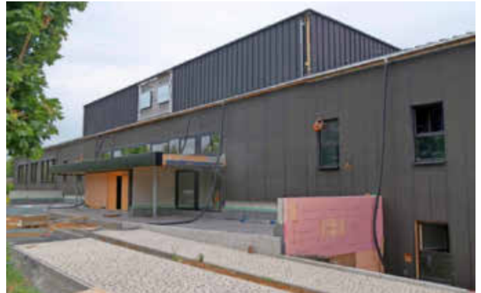
Der Bau der Grundschule Unterpleichfeld schreitet voran, aber die neue Schule wird nicht wie geplant zum Schuljahresanfang im September dieses Jahres fertig werden. Das Bild zeigt den Eingangsbereich der künftigen Pleichachtal-Grundschule.
