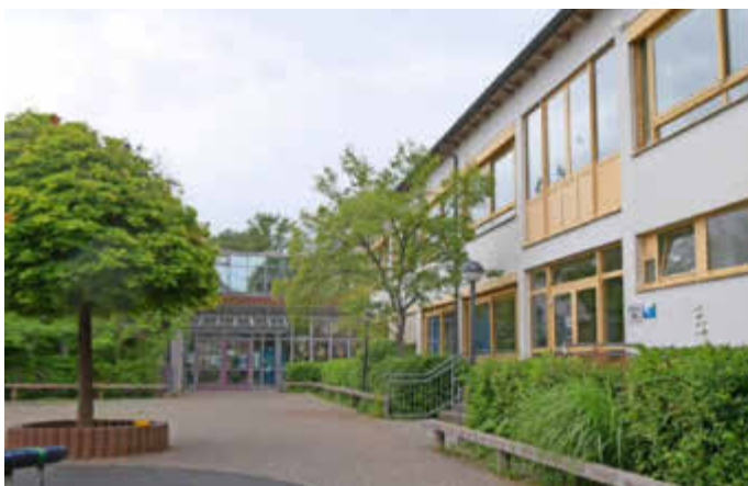
Die Grundschüler in Unterpleichfeld sind derzeit noch in einem gemeinsamen Schulgebäude mit den Mittelschülern des Schulverbands Pleichach-Kürnachtal beheimatet. Eigentlich sollten sie zum Schuljahresanfang im Herbst 2026 in das neue Schulgebäude in unmittelbarer Nachbarschaft umziehen. Die Raumsituation im derzeitigen Schulhaus ist angespannt. Fotos: Irene Konrad
