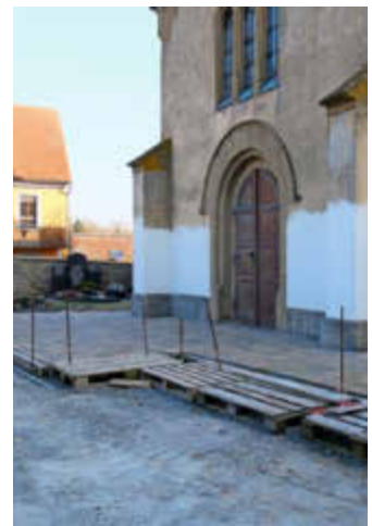
Die Friedhofssanierung in Rupprechtshausen schreitet voran. Die Pflasterarbeiten werden baldmöglichst fortgeführt.
