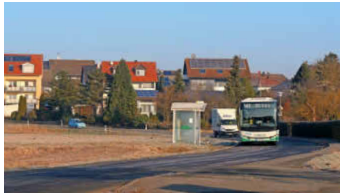
Die Austraße im Unterpleichfelder Ortsteil Burggrumbach wird in diesem Jahr generalsaniert. Im Moment stimmen das Staatliche Straßenbauamt, die Gemeinde und die Ingenieure die Termine und Umleitungsstrecken der Bauabschnitte ab. Auch die Bushaltestelle ist betroffen. Fotos: Irene Konrad
