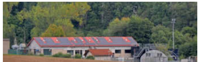
Die Verbandskläranlage des Zweckverbands Abwasserbeseitigung „Obere Pleichach“ liegt an der Pleichach westlich von Unterpleichfeld. Zum 1. Oktober 2025 wurde ihr Verwaltungssitz von der Verwaltungsgemeinschaft Bergtheim hierher verlegt. Das zieht eine Reihe an Aufgaben und Regelungen mit sich. Foto: Irene Konrad
