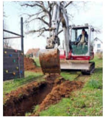
Für die Erweiterung des Nahwärmenetzes in Hausen werden Gräben gezogen, um die Wärmeleitungen zu verlegen. Foto: Irene Konrad
