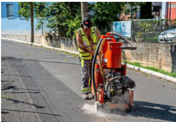
Aufschnitt der Verbindungsnaht Foto: Fotofreunde Güntersleben
