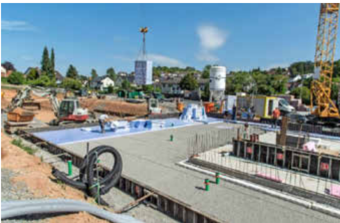
Legen der Bodenplatte
