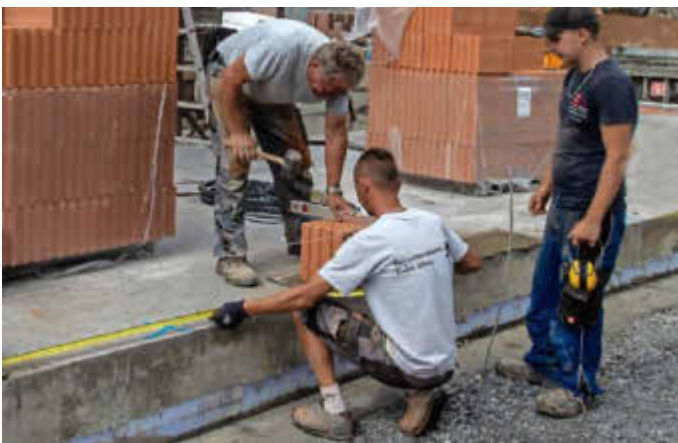
Ausführen der ersten Mauerwerksarbeiten
