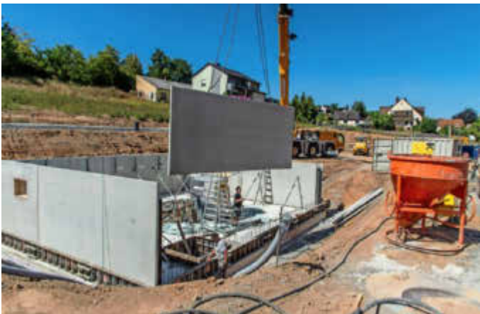
Aufstellen der Wände
