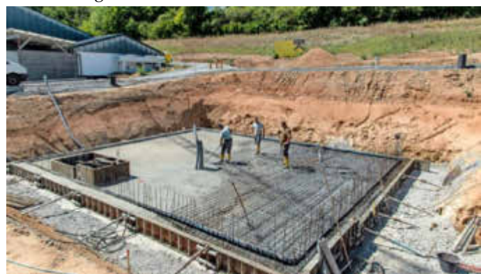
Betonieren der Bodenplatte Foto: Fotofreunde Güntersleben
