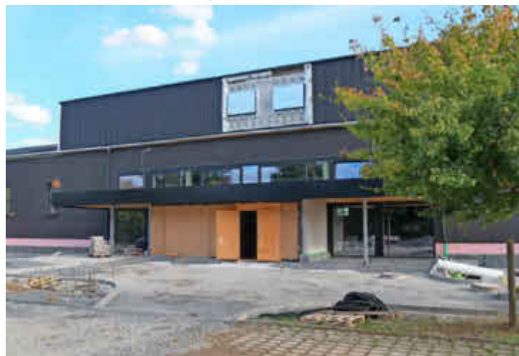
Der Neubau der Grundschule in Unterpleichfeld schreitet voran. Der Gemeinderat diskutierte nun, ob angesichts der heißen Sommermonate noch eine zusätzliche zentrale Klimaanlage eingebaut werden soll.
