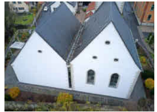
Der Westgiebel der Kirche St. Martin in Burggrumbach nach der Renovierung.
