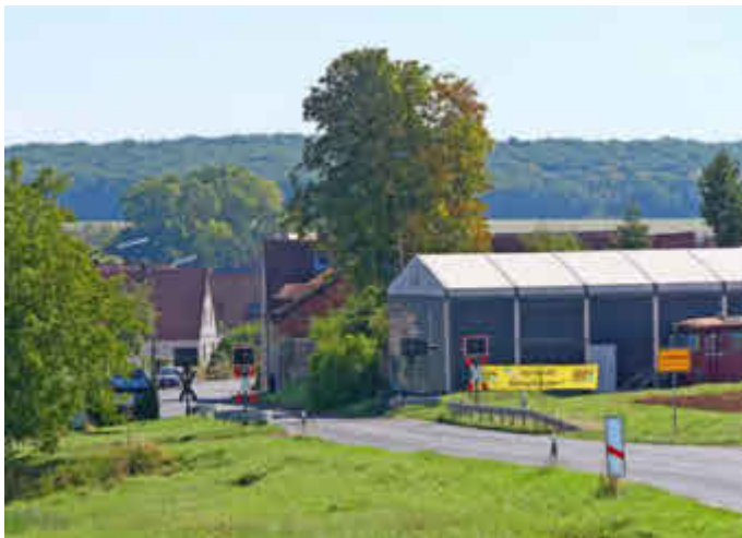
Am Ortseingang in der Oberpleichfelder Straße entsteht die Zufahrt zum künftigen Park-und-Ride-Platz der Gemeinde Prosselsheim. Dieser Bahnübergang wird im Zuge der Reaktivierung mit einer Schranke gesichert. Fotos: Irene Konrad
