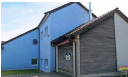
Der 2004 errichtete Anbau an das Gebäude der Grundschule in Erbshausen-Sulzwiesen ist Bun- ker für Hackschnitzel und Heizzentrale für ein klei- nes Nahwärmenetz. Foto: Irene Konrad
