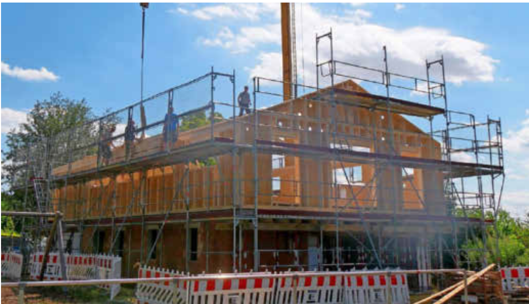
Ein großer Kran in der Schulstraße weist schon von Weitem auf das Bauprojekt des neuen Vereinszentrums des TSV Unterpleichfeld hin. Die Bauteile für Wände und Dach sind bereits montiert.
