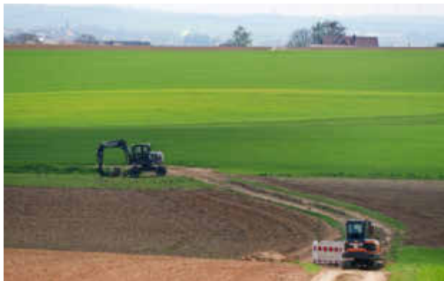
Die Energiewende macht sich auch in der Gemeinde Hausen bemerkbar. Bei der Kabelverlegung zum Umspannwerk Bergtheim werden öffentliche Wege mitgenutzt. Sie werden nach Abschluss der Baumaßnahme wieder „zur Zufriedenheit der Gemeinde erneuert“. Foto: Irene Konrad
