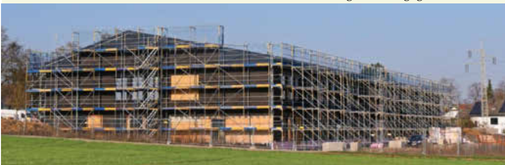
Große Pläne, große Investition: Das weitläufige Gerüst zeigt die Dimensionen des neuen Schulzentrums, das für rund 23 Millionen Euro gebaut wird. Ein Großteil des Haushalts fließt in dieses Zukunftsprojekt. Foto: Irene Konrad
