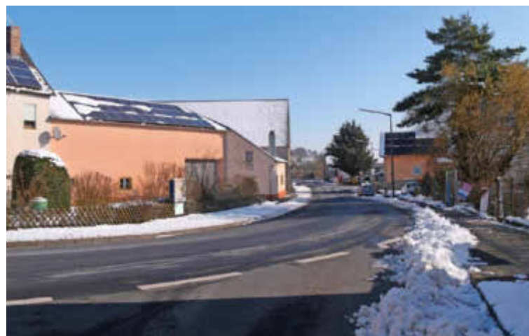
Die Staatsstraße 2260 schlängelt sich durch Prosselsheim. Seit Jahren wartet die Gemeinde auf die Ortsumgehung und hat dafür 2013 sogar die Kommunale Baulast übernommen, um deren Planung und Bau zu beschleunigen. Nun wurde sie von ihrer damals eingegangenen Zahlungsverpflichtung befreit. Foto: Irene Konrad
