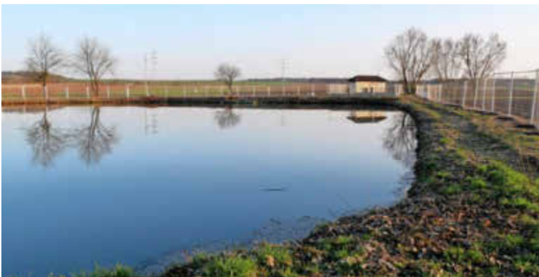
Bald geht es los mit der Erneuerung der Kläranlage – die vorbereitenden Arbeiten und die finalen Pläne sind eingereicht. Foto: Irene Konrad
