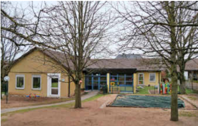
Der Kindergarten St. Sebastian wurde 1978 gebaut und muss dringend saniert und möglicherweise angebaut werden. Der Grund und das Gebäude gehören nun der Gemeinde Oberpleichfeld.
