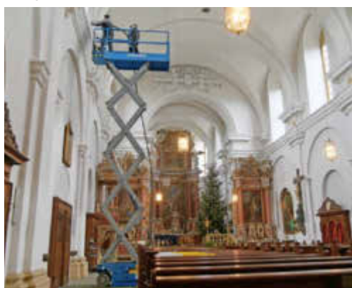
Mit einer Scherenhebebühne und einem Industriestaubsauger wurden in der Wallfahrtskirche Fährbrück Mauervorsprünge und Nischen in luftiger Höhe gereinigt. Foto: Irene Konrad
