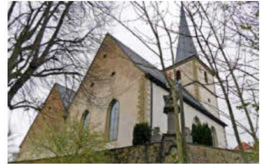
*An der Westfassade der Pfarrkirche St. Martin in Burggrumbach sind Putz und Gesimse abgefallen. Die Kirchenverwaltung geht davon aus, dass beide Giebel eingerüstet und auf lockeren Putz geprüft werden müssen. Deshalb bat sie, im Haushalt 2024 einen Beitrag zur Deckung eines Zuschusses einzustellen. Foto: Irene Konrad*
