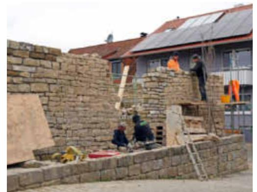
Aus den Steinen eines abgerissenen Wohnhauses wird am Kreisel, der Kreuzung der Kreisstraßen Wü 3 und Wü 5, eine Steinmauer neu aufgebaut. Sie wird noch verputzt und abgestrahlt. Dann soll der Platz davor mit einem Laubengang hübsch gestaltet werden. Foto: Irene Konrad
