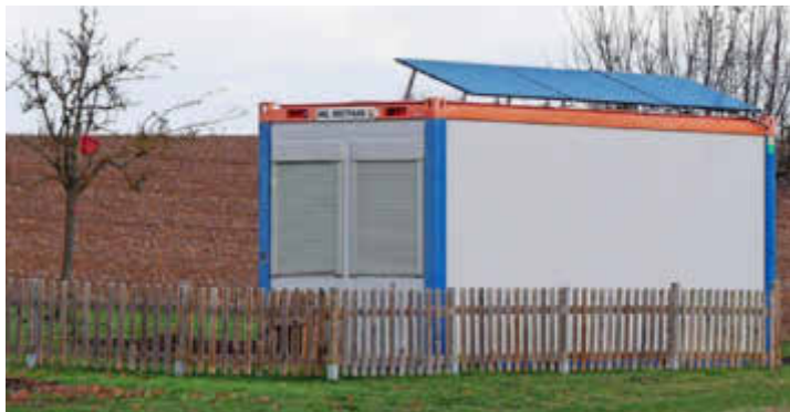
Die ErbsBOX als Treff für Jugendliche wurde auf dem Gelände der DJK Erbshausen-Sulzwiesen aufgestellt. Dank ihrer Photovoltaikanlage mit Batterien ist der Strom im Container unabhängig.
